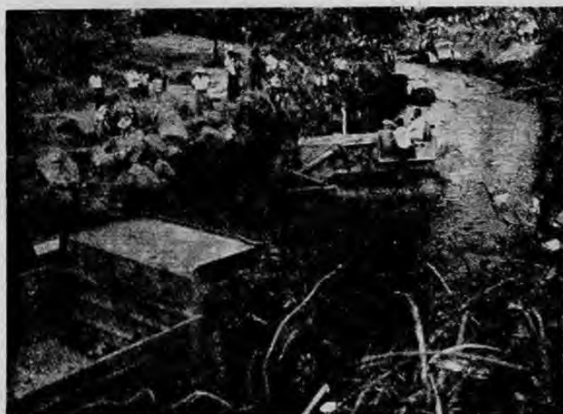
Hace algunos días maquinaria pesada de Defensa Civil comenzó a trabajar en el dragado del Río María Aguilar, en la sección que atraviesa los barrios del Sur de San José y pasa detrás de las ciudades del INVU por el lado Norte. Allí se ha venido formando una peligrosa presa, que si no se remueve antes de que entre el invierno, provocaría de nuevo inundaciones y daños.
