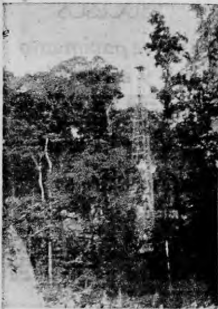
En zonas verdaderamente inaccesibles es que se realiza la perforación de los pozos petroleros. Es necesario construir vías de acceso, que luego puedan dar beneficio de los vecinos, habilitando tierras. Al fondo de la gráfica, una de las torres de perforación, de los trabajos que hiciera la Unión Oil. (Foto Zeledón).
